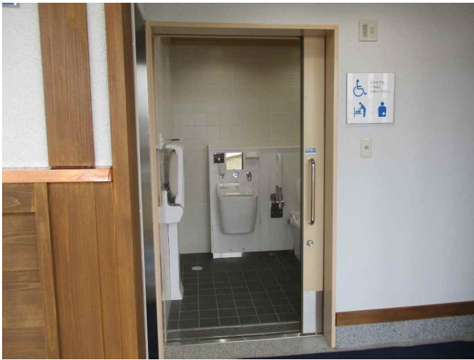
多目的トイレ入り口
