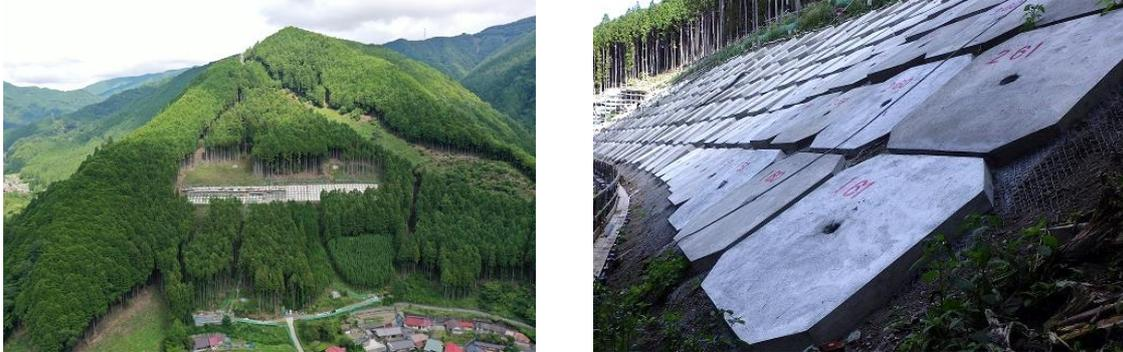
写真-2 現在の進捗状況（左：航空写真、右：台座モルタル吹付完了）
