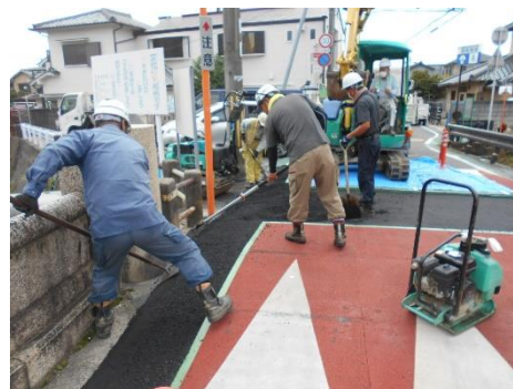
写真4 路肩部の擦り付け
