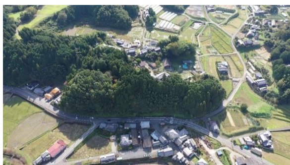
写真-4 工事着手前(1)
