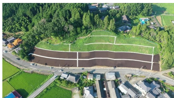
写真-5 工事完了後(1)
