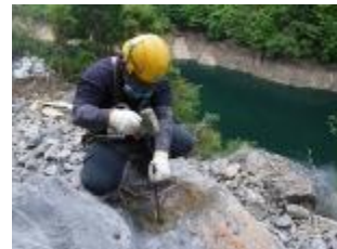
カートリッジ装填、タンピング
