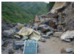
防音・防爆シート設置
