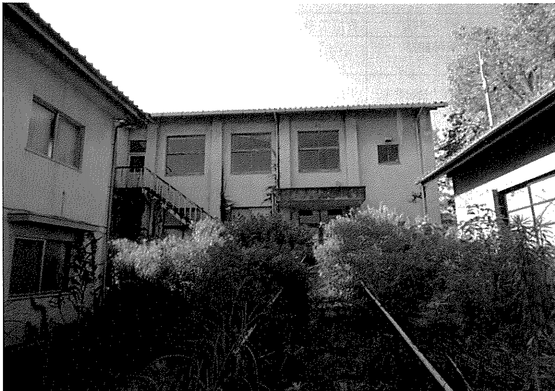
敷地内中央より撮影
