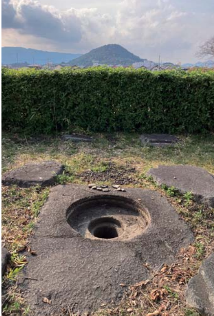
東塔基壇上の礎石と心礎(東から撮影) 塔を支える心柱の礎石には柱孔、その内側に仏舎利(釈迦のお骨)を納める舎利孔がみえます。正面(西側)には畝傍山がみえます。
