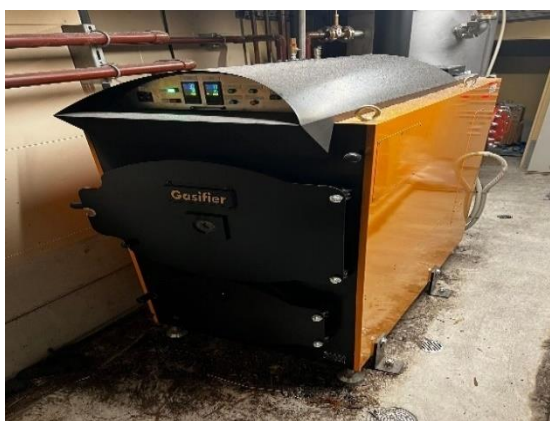
薪ボイラーの設置（御所市内）
