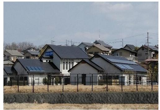
福祉施設への太陽熱利用システムの導入
