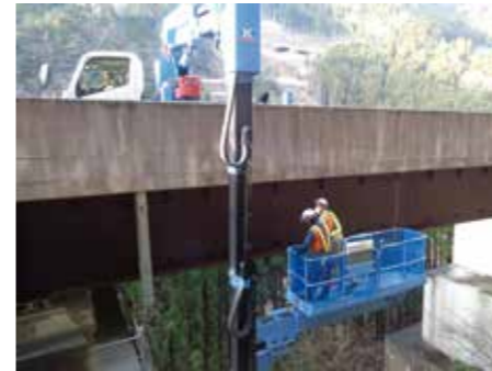
(維持管理・リニューアル工事)
