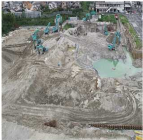
旧奈良県総合医療センター(除却)
