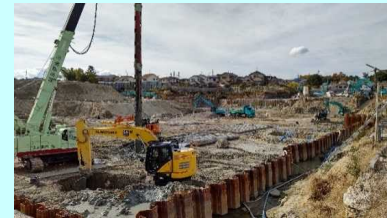
除却工事の進捗状況(R4.12)
