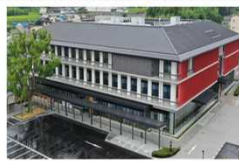
五條市役所庁舎と県事務所等の合同庁舎
