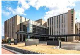
新奈良県総合医療センター
