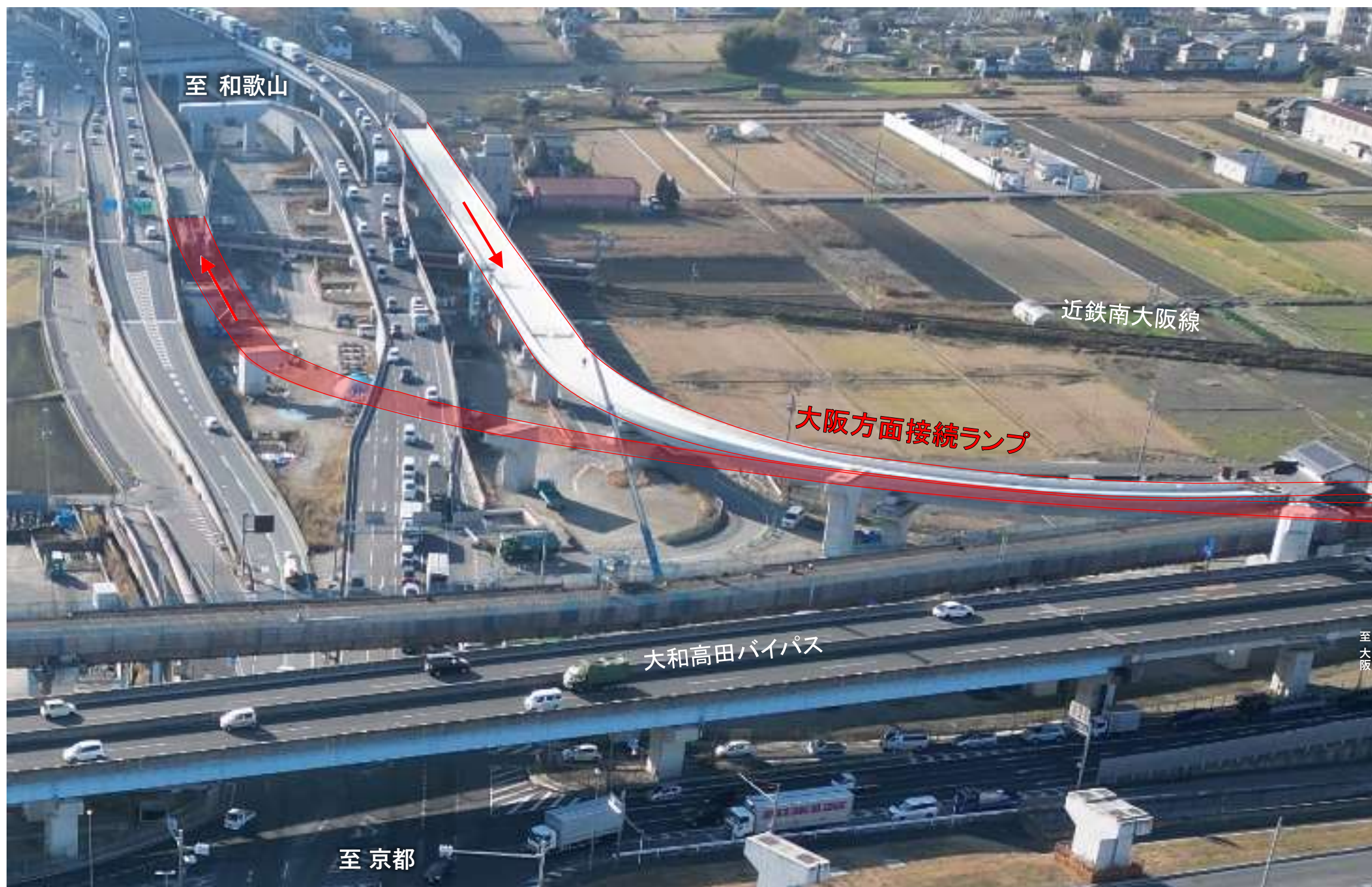
京奈和自動車道大和御所道路（橿原市新堂町） 橿原北IC～橿原高田IC間の高架橋の上下部工事の状況
