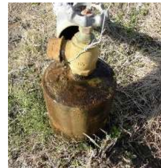
現状の給水栓 （手で開閉）
