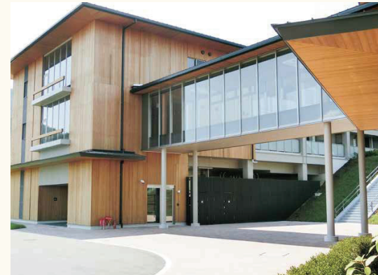
■外壁、ルーバー施工例
