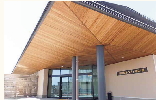
■軒天井施工例
