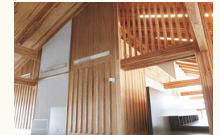
■内装壁施工例
