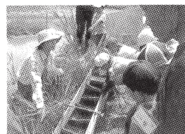
水田魚道の整備
