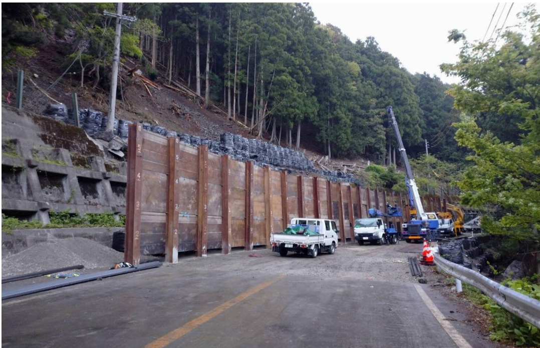
4/25(火)現場状況写真
