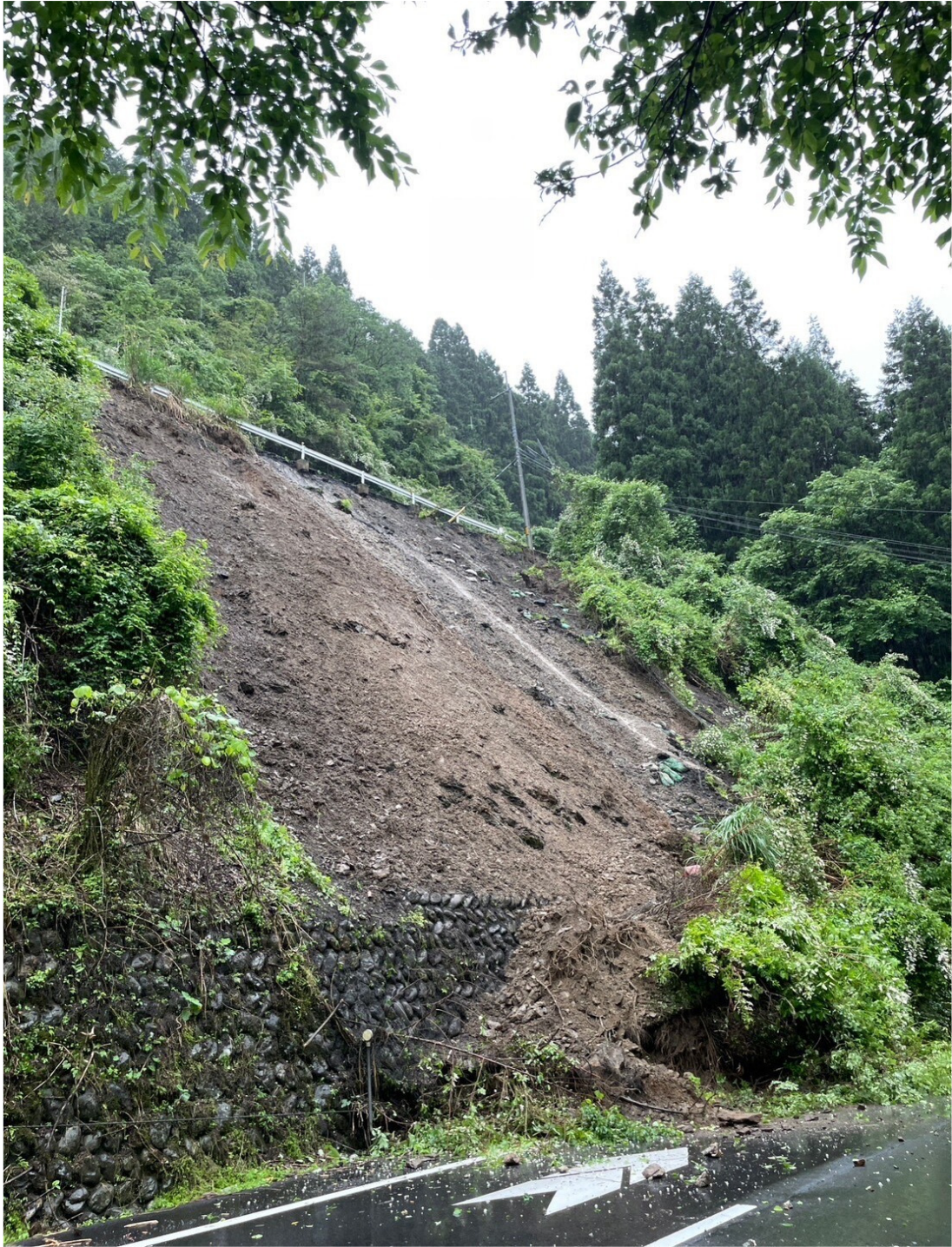
R168 崩土現場写真
