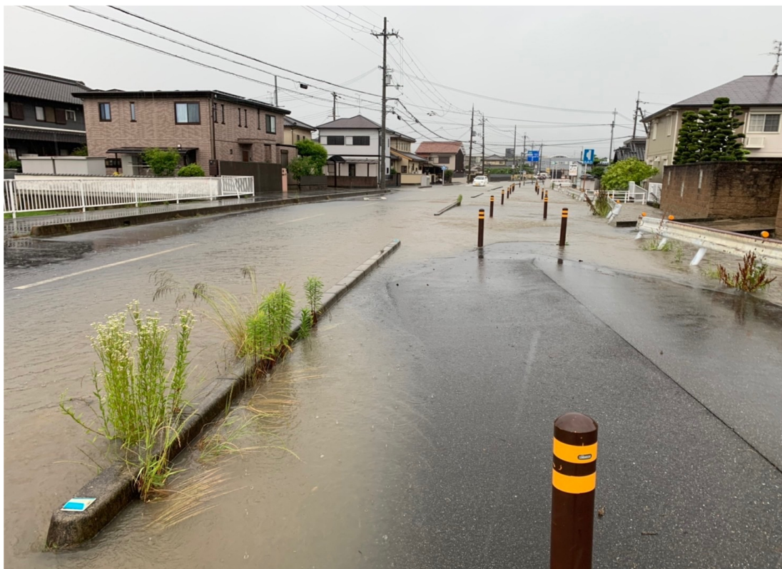
天理斑鳩線冠水現場写真
