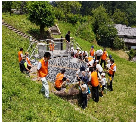
【集水井の現物を確認】
