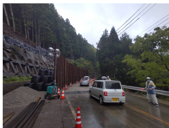
図3 交通開放時の誘導状況
