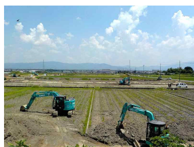
写真-1 区画拡大工事の風景
