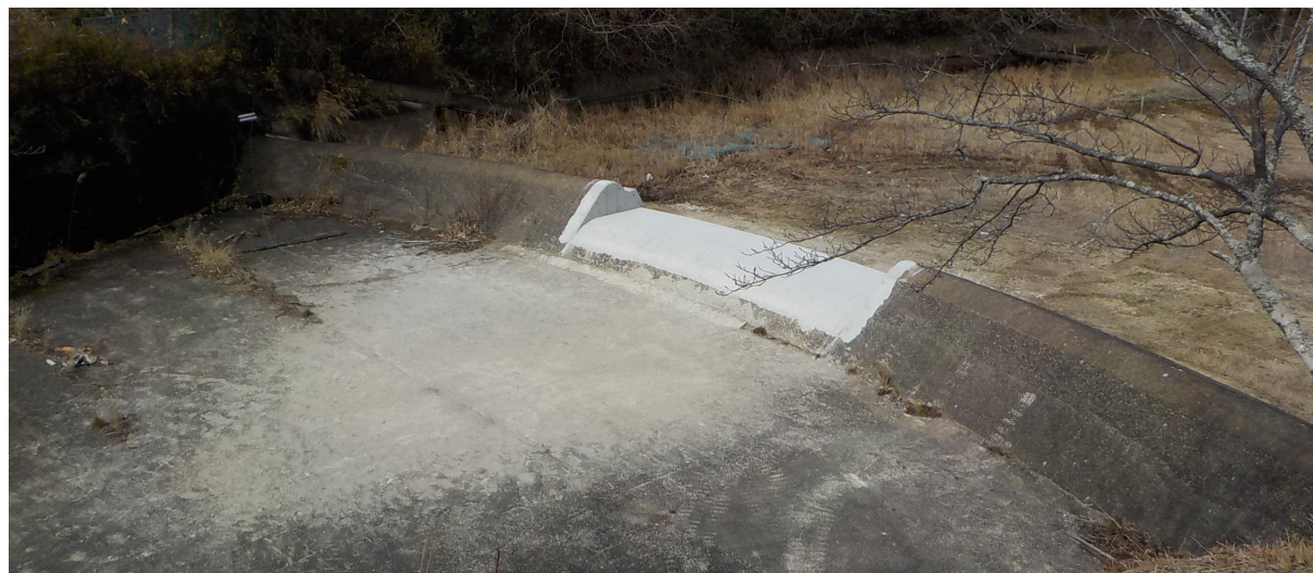
写真 2-スリット施工後の洪水吐
