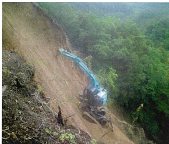
ロッククラッキング工法 による切土
