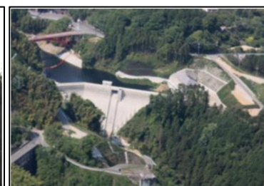
ダム (大門ダム)
