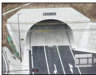
トンネル (栄山寺TN)
