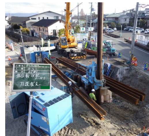
市街地施工で要騒音対策
