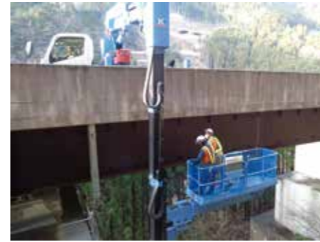
(維持管理・リニューアル工事)
