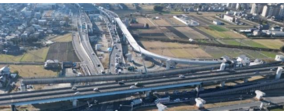
京奈和自動車道等の整備
