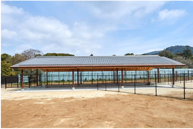
中央棟（南西側）
