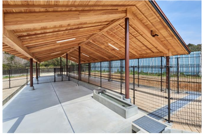
中央棟（餌場・給水場）
