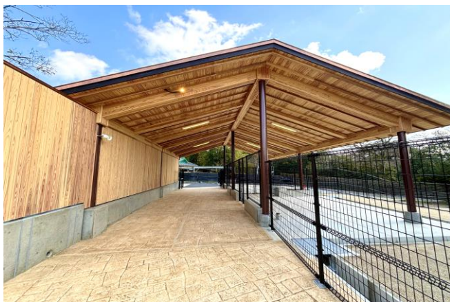
東棟B 見学者通路
