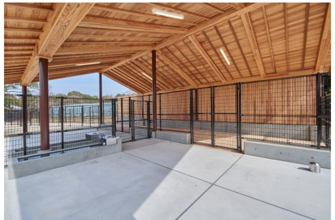
東棟B 内部
