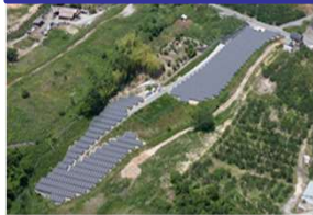
太陽光発電施設
