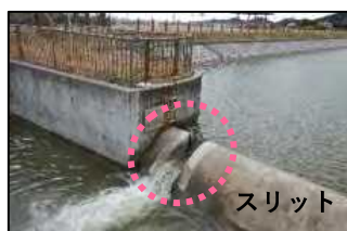
▲スリットの設置状況
