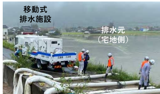
樋管のゲートにポンプを設置
