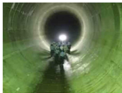
雨水貯留管の整備
