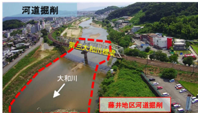
奈良県藤井地区第三大和川橋梁
