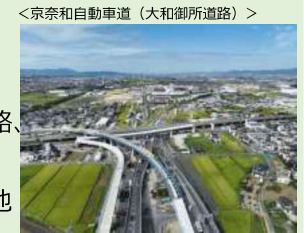
(仮称)橿原JCT(大阪方面接続ランプ) 【令和8年春供用】
