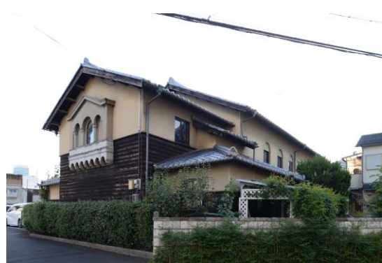
会堂外観(北東より)
