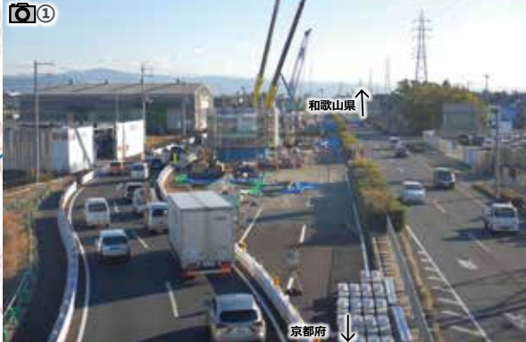
▲（仮称）奈良IC～郡山下つ道JCTの工事状況
