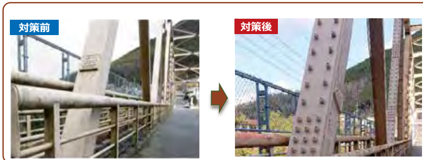
▲当て板補強による補修工事
