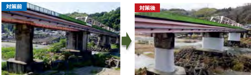
▲橋脚巻立て工による耐震補強工事（桜井吉野線 桜橋）
