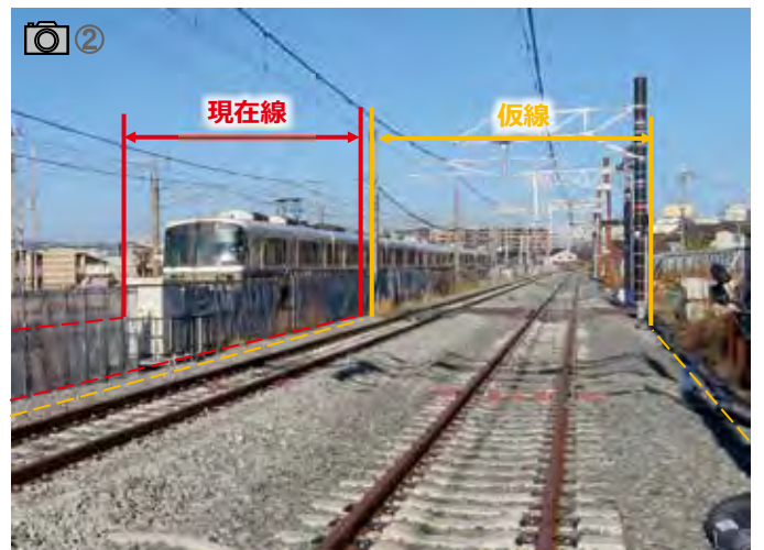
▲ 南大安寺踏切付近 (仮線路工事)
