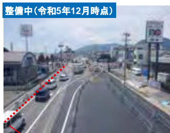
既存ストック埋設箇所
