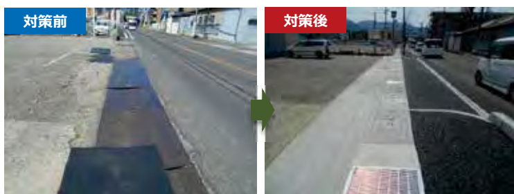
▲歩道設置（国道166号 葛城市尺土）
