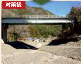
▲ 橋梁の補修工事 (国道168号河津橋)
