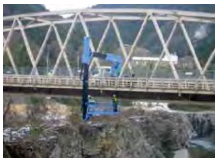
▲橋梁の定期点検
