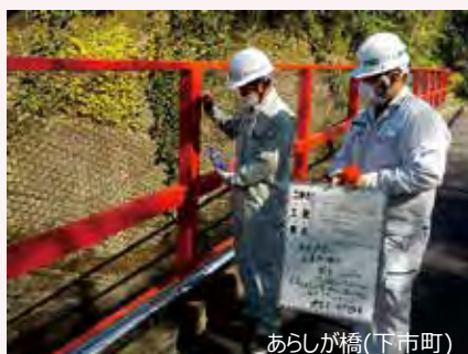
▲県が修繕工事を受託した橋梁の検査を 県職員と市町村職員が一緒に実施
