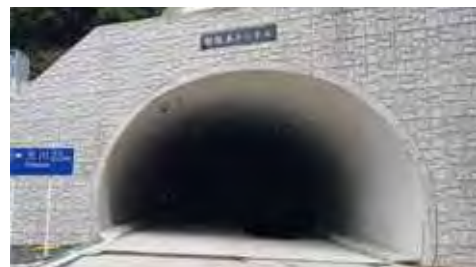
▲新阪本トンネル
