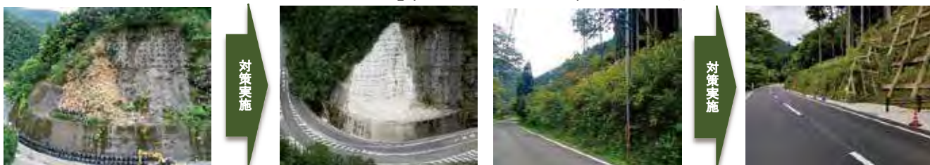
▲法面対策（国道168号 十津川村野尻）
