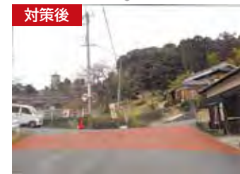
▲交差点のカラー舗装化(山稜王寺線 王寺町本町)
