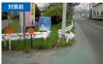
▲通学通園路の合同点検で対策が必要となった箇所 (国道168号 生駒郡平群町吉新)
