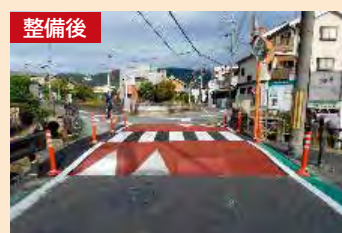
▲スムーズ横断歩道の整備
