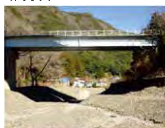
▲ 橋梁の補修工事
