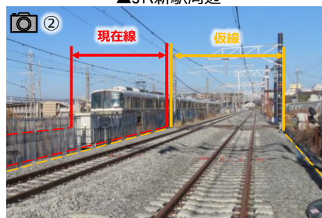
▲南大安寺踏切付近(仮線工事)
