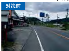
右折車が交差点中心寄りに待機し対向車と衝突
