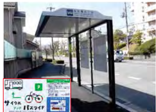
▲バス停の改良と周辺施設の駐車場を活用したサイクルアンドバスライド（馬見南六丁目）
