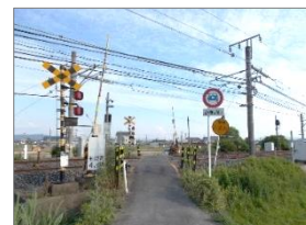
▲中八条踏切道
