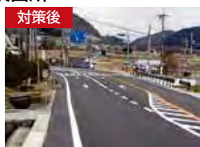
右折レーンを設置し衝突の危険性を軽減
