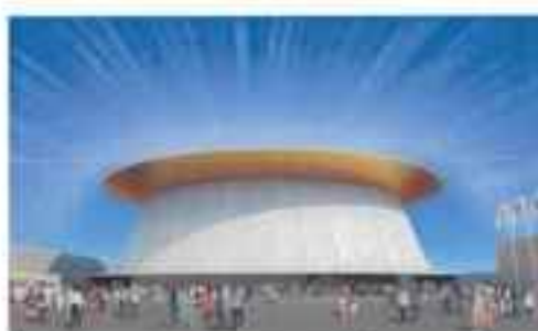
EXPOホール (仮称) 外観
