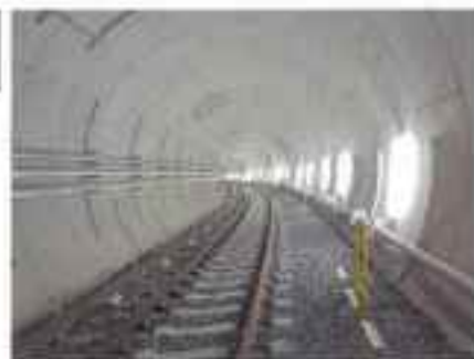
シールド部 (レール設置)
