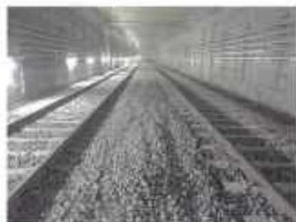
沈埋部 (レール設置)
