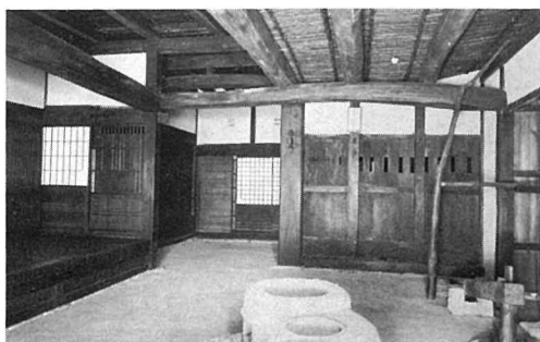
▲ 第2図 移築後土間
