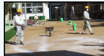
土が流れないように 転圧し凝固剤を散布
