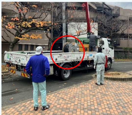
12/5 9時に高圧ケーブル到着
