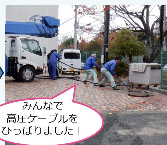
高圧ケーブルの入替作業中
