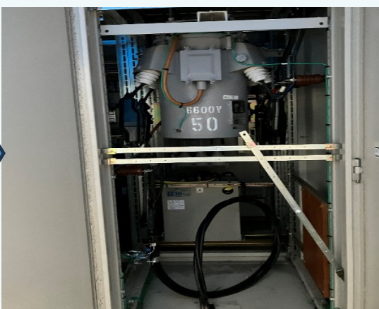
同日 16時頃 作業完了
