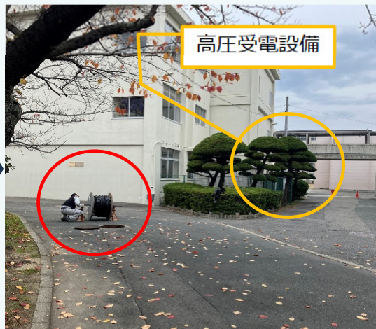
高圧ケーブルの入替作業前
