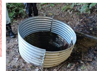
写真3 西エリア内の横断管の流入口
