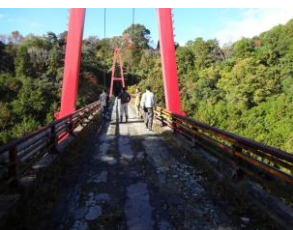
両エリアをつなぐ橋
