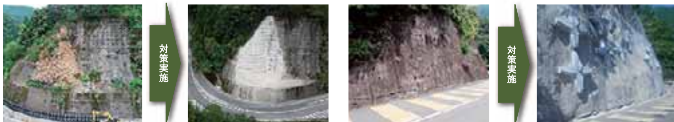
▲法面对策（国道168号 十津川村野尻）
