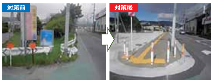
▲歩道設置（国道168号 生駒郡平群町吉新）
