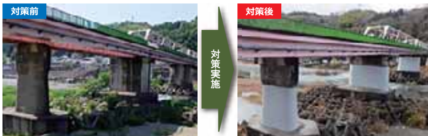
▲橋脚巻立て工による耐震補強工事（桜井吉野線 桜橋）
