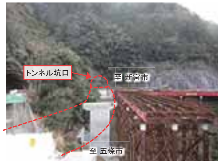
▲工事の様子 令和7年1月 撮影
