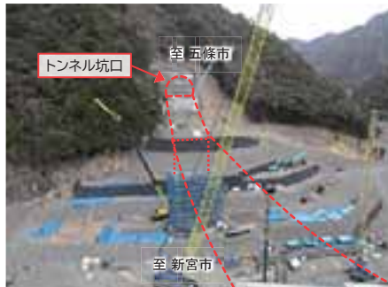
▲工事の様子 令和7年1月 撮影
