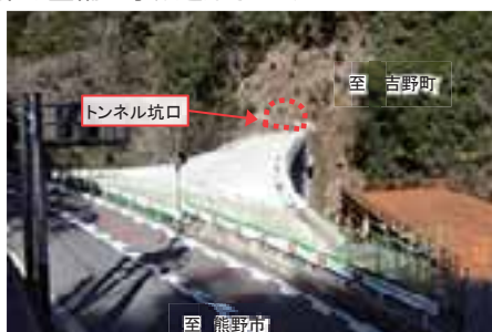
▲工事の様子 令和7年1月 撮影
