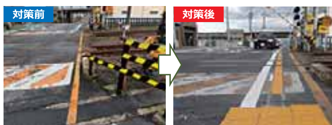
▲視覚障害者誘導標示設置（国道169号 桜井市谷）
