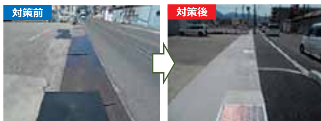
▲歩道設置（国道166号 葛城市尺土）
