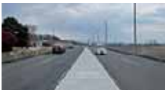
▲コンクリートを使用した防草対策令和6年度 防草対策工事 完了箇所（大和郡山環状線 大和郡山市城町工区）
