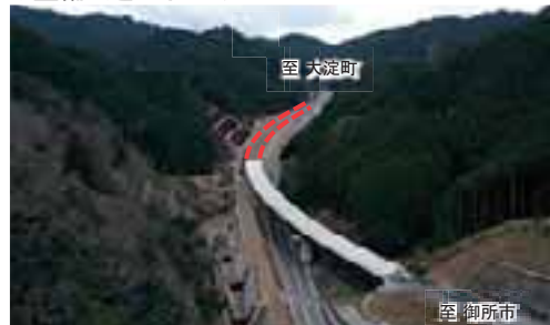
▲工事の様子 令和7年1月 撮影
