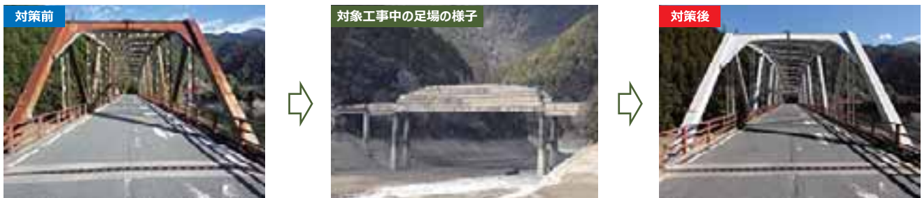
▲橋梁の補修工事前後 (国道169号 白川橋)
