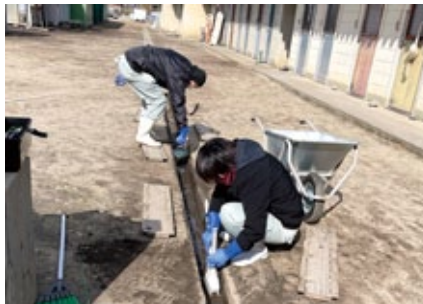
溝の泥あげ作業
