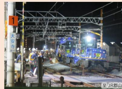
私は主に都市計画道路の整備及び鉄道高架化の事業に携わっています。鉄道高架化により踏切が除却されることで踏切事故や地域分断の解消にもつながり、併せて実施される道路整備により奈良市中心市街地へのアクセス性が向上します。左の写真はR6年4月に実施した仮線への切換状況です。当日は、一晩で現在線から仮線への切換をおこないました。約700人での作業と非常に大がかりな作業に立ち会うことができ、貴重な経験となりました。
