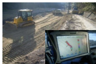
▲ICT建設機械による施工
