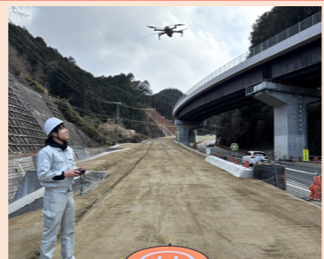
▲ドローンを用いた現場状況写真撮影の様子
