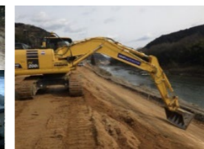
▲ICT建設機械による施工
