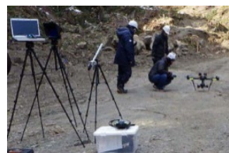
▲ドローン等による3次元測量
