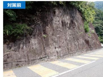
▲ コンクリート吹付及びアンカー工による法面対策（一般国道168号 十津川村川津工区）
