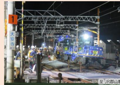
私は主に都市計画道路の整備及び鉄道高架化の事業に携わっています。鉄道高架化により踏切が除却されることで踏切事故や地域分断の解消にもつながり、併せて実施される道路整備により奈良市中心市街地へのアクセス性が向上します。左の写真はR6年4月に実施した仮線への切換状況です。当日は、一晩で現在線から仮線への切換をおこないました。約700人での作業と非常に大がかりな作業に立ち会うことができ、貴重な経験となりました。
