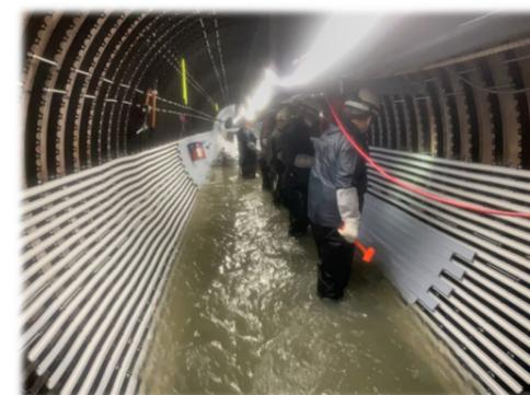
管渠の長寿命化工事(更正工法による改築)
