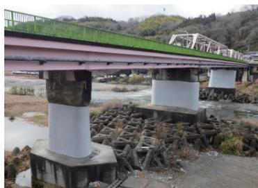
▲ 橋脚巻立て工による耐震補強工事
