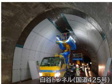
▲ トンネル補修工事の様子（成型版接着工）
