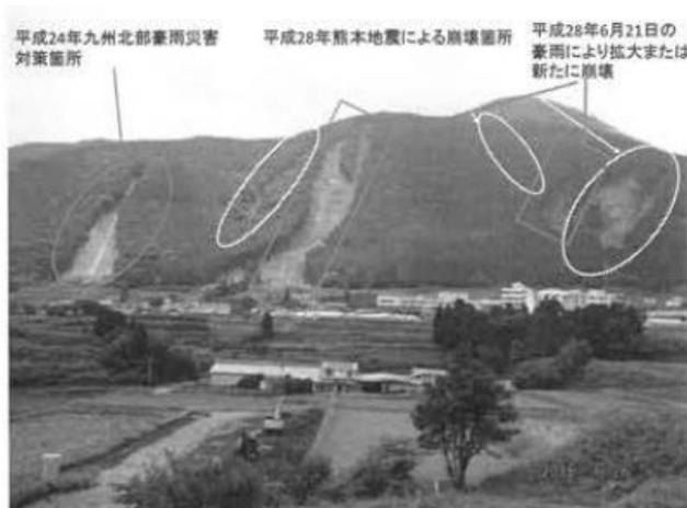
写真-10 豪雨によって土砂災害が拡大
