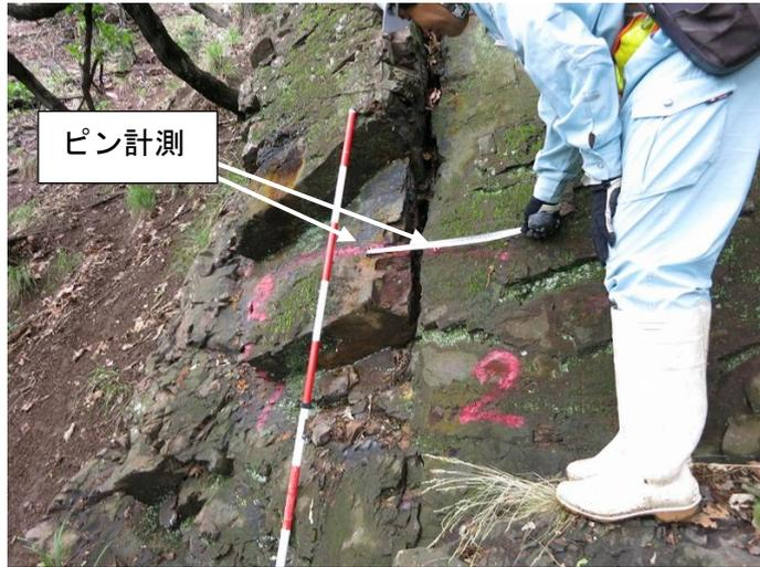
図- 7.6 不安定岩塊の亀裂にピンを設置しピン計測で監視している事例
