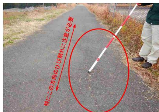
② 舗装に隙間があると、そこから雨水が浸み込み堤体を弱くします
