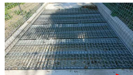
テキサスゲート シカ・イノシシの蹄が隙間に挟まるため、 圃場への侵入を防止
