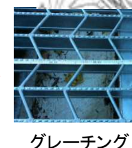
テキサスゲート シカ・イノシシの蹄が隙間に挟まるため、 圃場への侵入を防止
