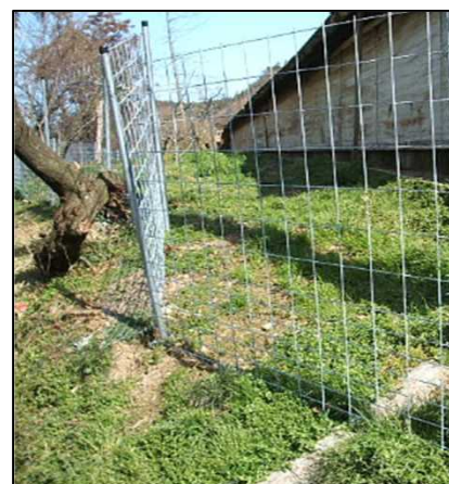
＜野生動物侵入防止フェンス＞
