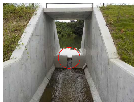
ため池を活用した治水利用
