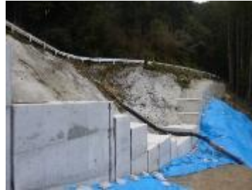
① コンクリート基礎工
