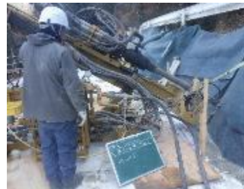
③ アンカー工
