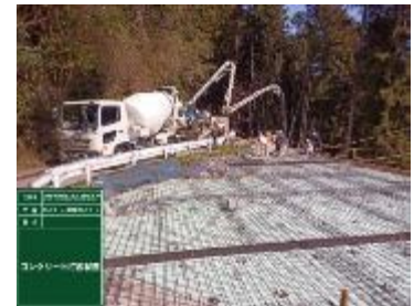
④ コンクリート床板工
