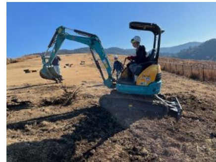
根径掘取り施工状況
