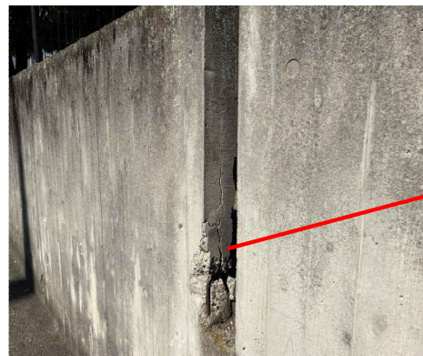
◀鉄筋が露出（トラックヤード）
