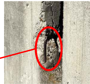
◀鉄筋が露出（トラックヤード）
